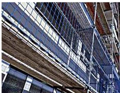
Für Seitenschutznetze und Netze in Dachfangerüstern sind die EN 1263-1, die DIN EN 13374 sowie für die Montage die EN 1263-2 und die DGUV-I 201-023 maßgebend. Diese Netze werden als Schutznetzsystem U (Schutznetz in Tragkonstruktionen für vertikale Verwendung) bezeichnet. Bei Einsatz von Netzen kann auf den Zwischenholm verzichtet werden. Ringsum werden die Netze mit einem angeketteten Einfasseeil versehen. Aus Polypropylen hochfest, ca. 5 mm, mit angekettetem Einfasseeil.
